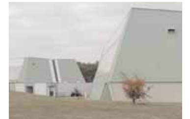
Le site des trois Cosec, sur les hauteurs de la ville. (Photo NR)
