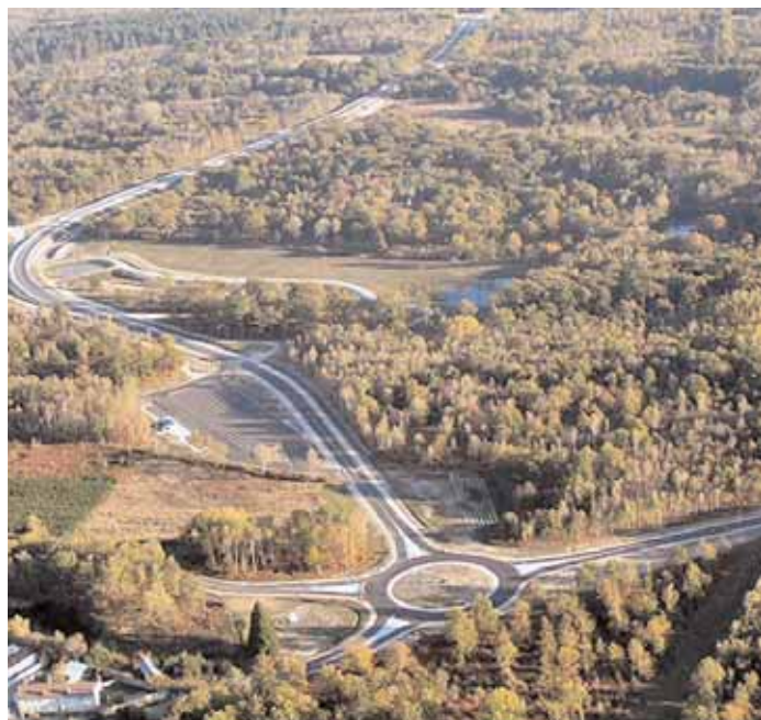
Le rond-point d'accès vers l'autoroute de la plate-forme logistique Prologis est déjà réalisé, avec le soutien du conseil général. (Photo sd)
